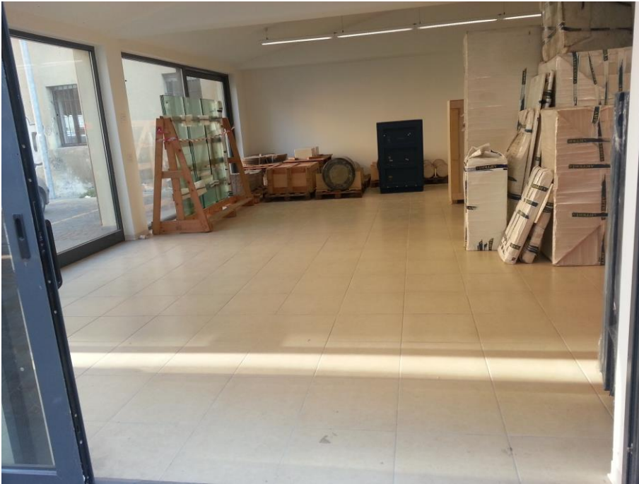
VISTA INTERNA – LOCALE PRINCIPALE
